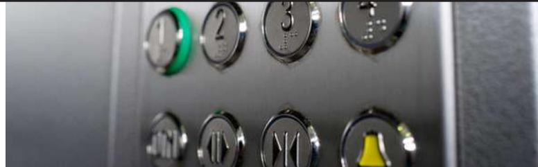
другой необходимой информацией (на кнопках или над ними). Следует предусматривать автоматическое звуковое и визуальное оповещение о номере этажа, на котором останавливается лифт. Расположенный в кабине аппарат двухсторонней переговорной связи с диспетчерским пунктом должен быть промаркирован шрифтом Брайля и снабжен устройством для усиления звука, а при необходимости — устройством для получения синхронной визуальной информации.
